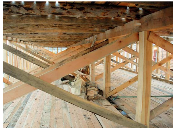
Midlertidig skråavstivning i 2. etasje.
